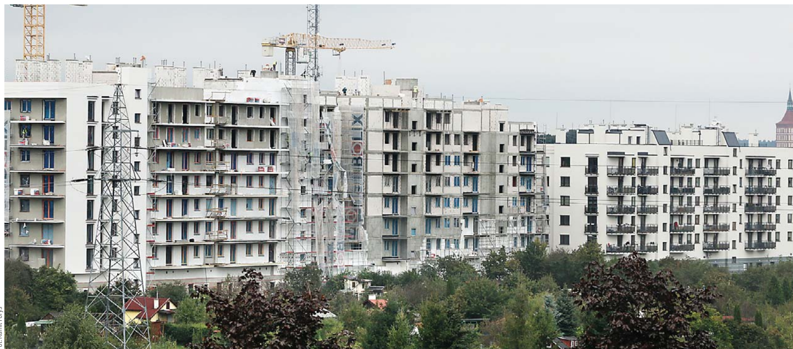
Budowa drugiego etapu projektu pod nazwą Zielone Tarasy przy al. Sikorskiego. Będzie tam 177 mieszkań, które zostaną oddane w marcu przyszłego roku
